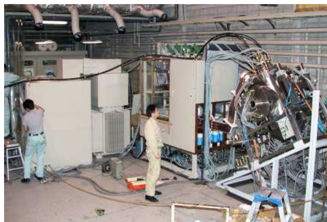
2000 VT300kW 減容装置
