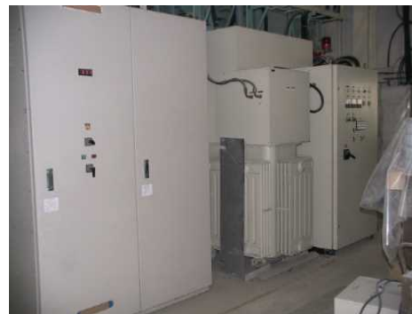
2001 VT300kW 減容装置
